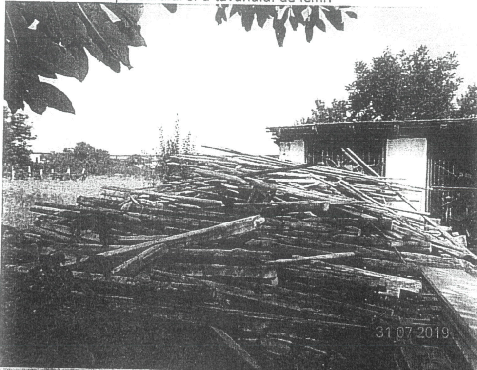
Material lemnos – provenit din demolarea sarpantei de acoperis a Dispensarului si a tavanului de lemn
